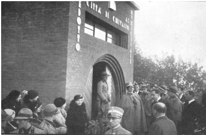
Chivasso 30 ottobre 1932 – Inaugurazione acquedotto alla presenza di Sua Altezza Reale il Principe di Piemonte Umberto di Savoia
